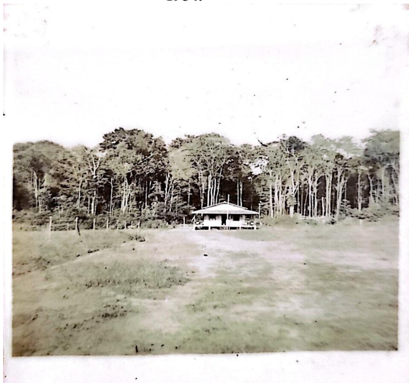
Foto 06: Moradia feita pelos japoneses- casa de palafita, Colônia do Matapi- 1954.
