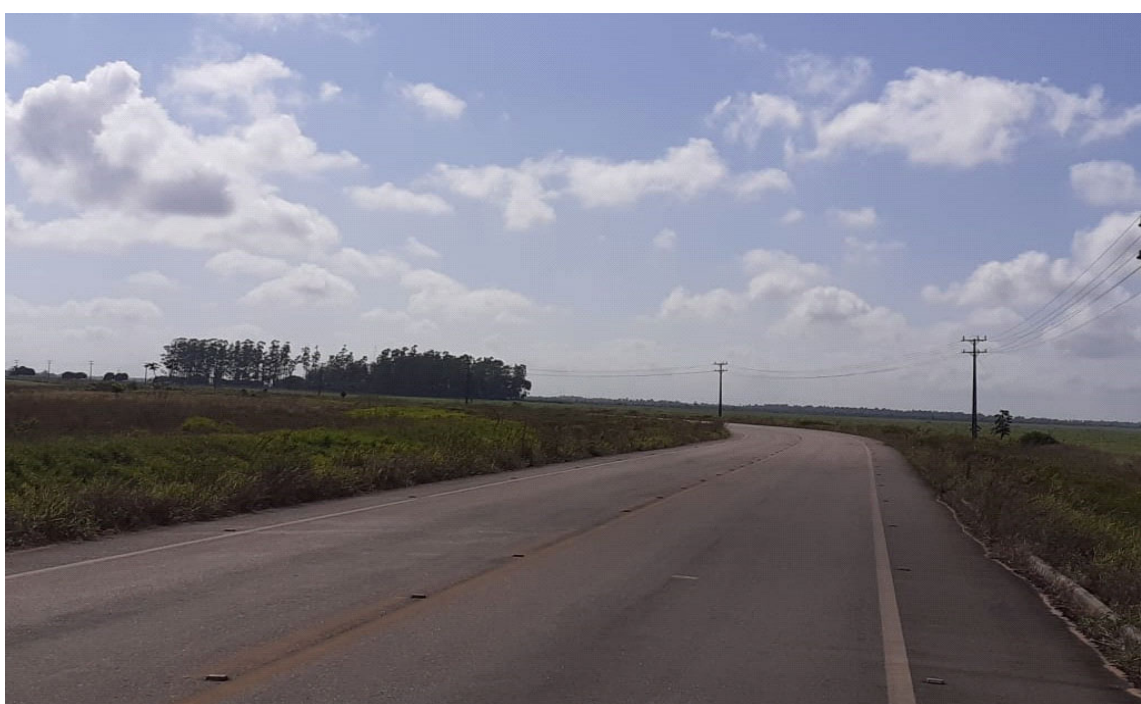
Figura 14 - Vista do trecho asfaltado da rodovia Estadual AP-340 em direção à sede do Município de Itaubal do Pírim.
