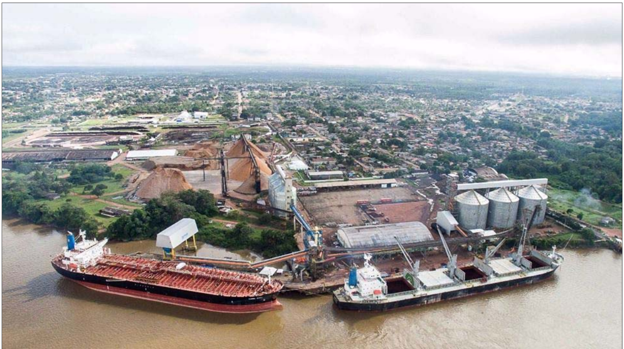
Figura 5 – Vista aérea de Santana evidenciando as atividades portuárias
