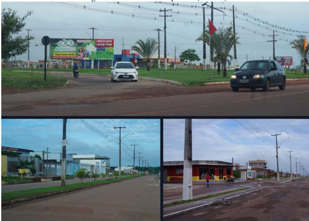
Figura 9 – Loteamento Acquaville (Santana)
