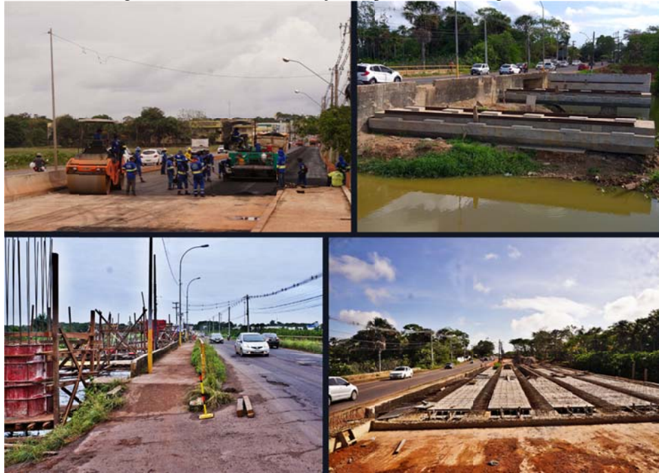
Figura 12 – Obras de construção da ponte sobre a Lagoa dos Índios
