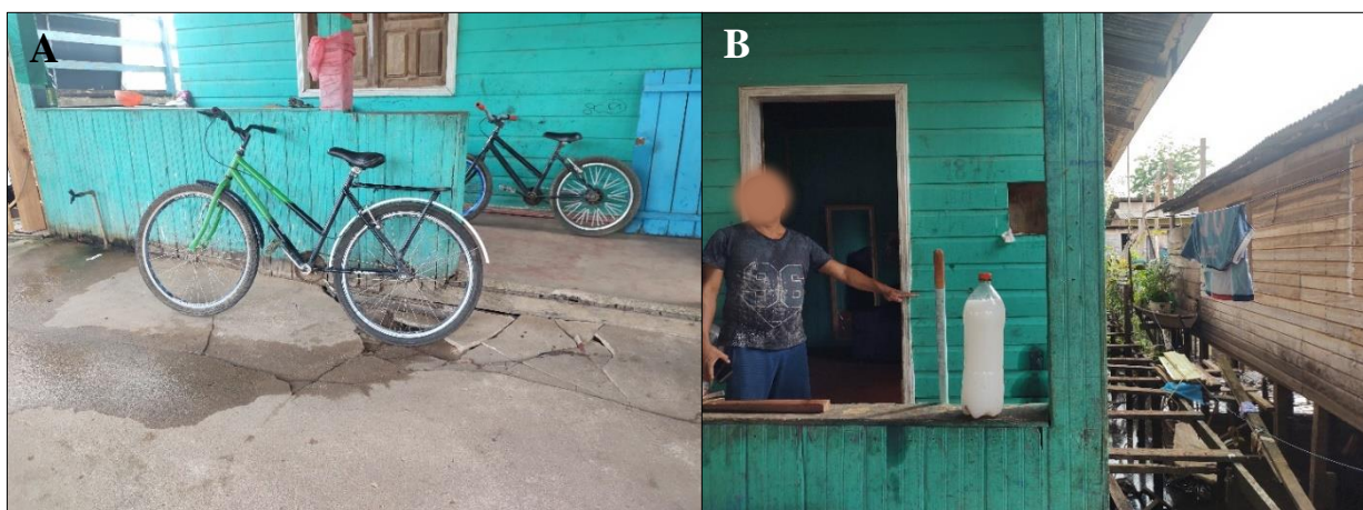
Figura 41 – (A) Calçada quebrada em residência construída sob solo saturado e (B) morador indicando o nível máximo da cheia do rio Jari registrado em sua casa.
