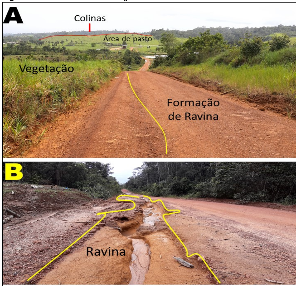
Figura 20. Estrada de acesso ao geomorfossítio Pedra do Abacaxi
