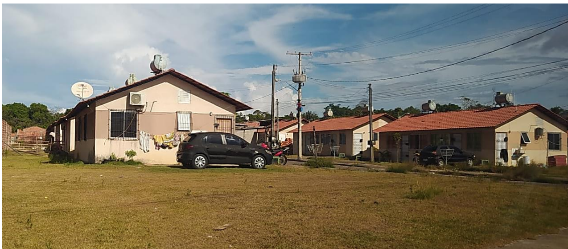
Figura 20- Fachada das casas no Conjunto Macapaba I e II
