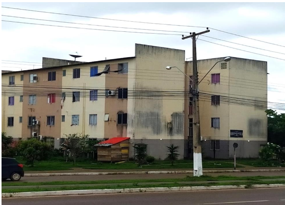
Figura 29 - Construções em anexo ao edifício
