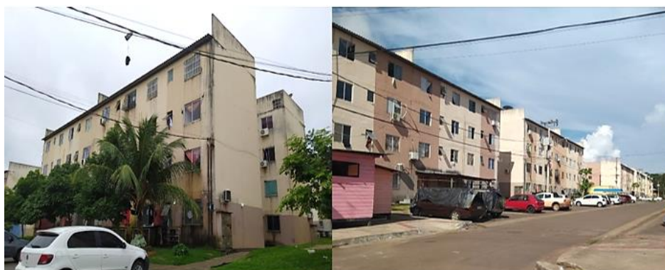
Figura 27 - Fachada dos edifícios
