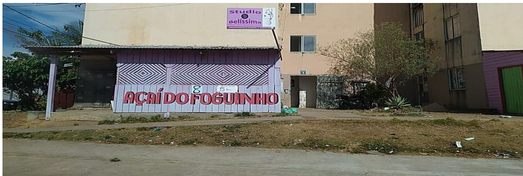
Figura 23- Fachada do edifício no Conjunto Macapaba I e II
