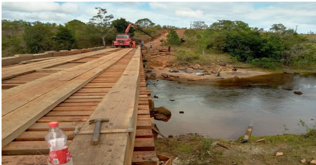
Imagem 5- Ponte em reforma- Ramal de Bom Jesus
