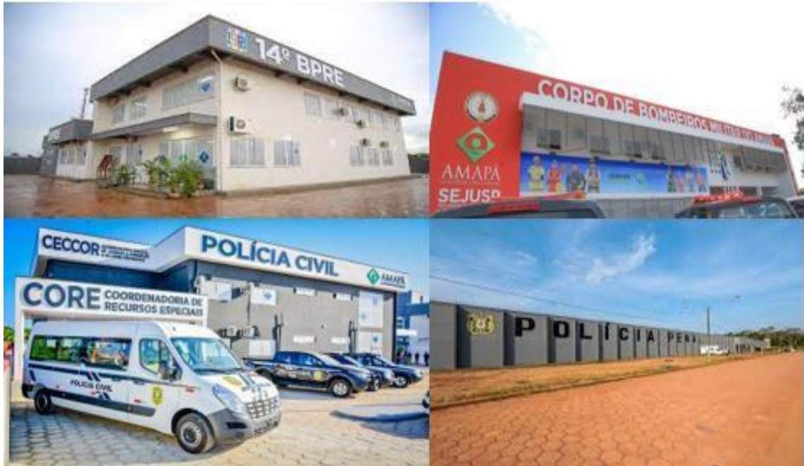
Figura 30 – Complexo de Segurança Pública Subcentro Zona Oeste
