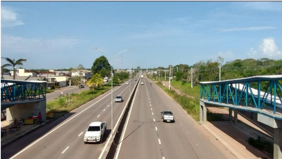
Figura 32 – Infraestrutura de acessibilidade Subcentro Zona Oeste
