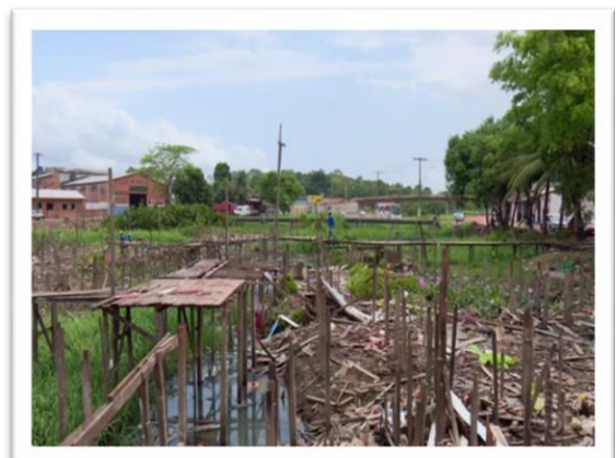
Figura 22: Aspecto do local após sua desocupação
