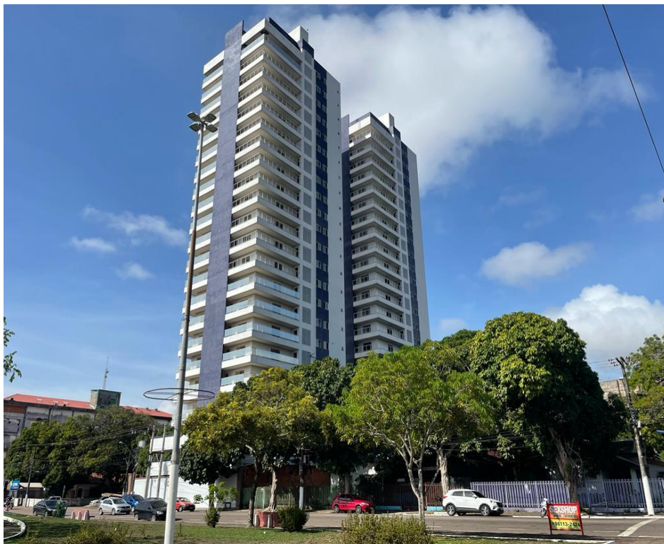
Figura 02 - Edifício Costa Norte
