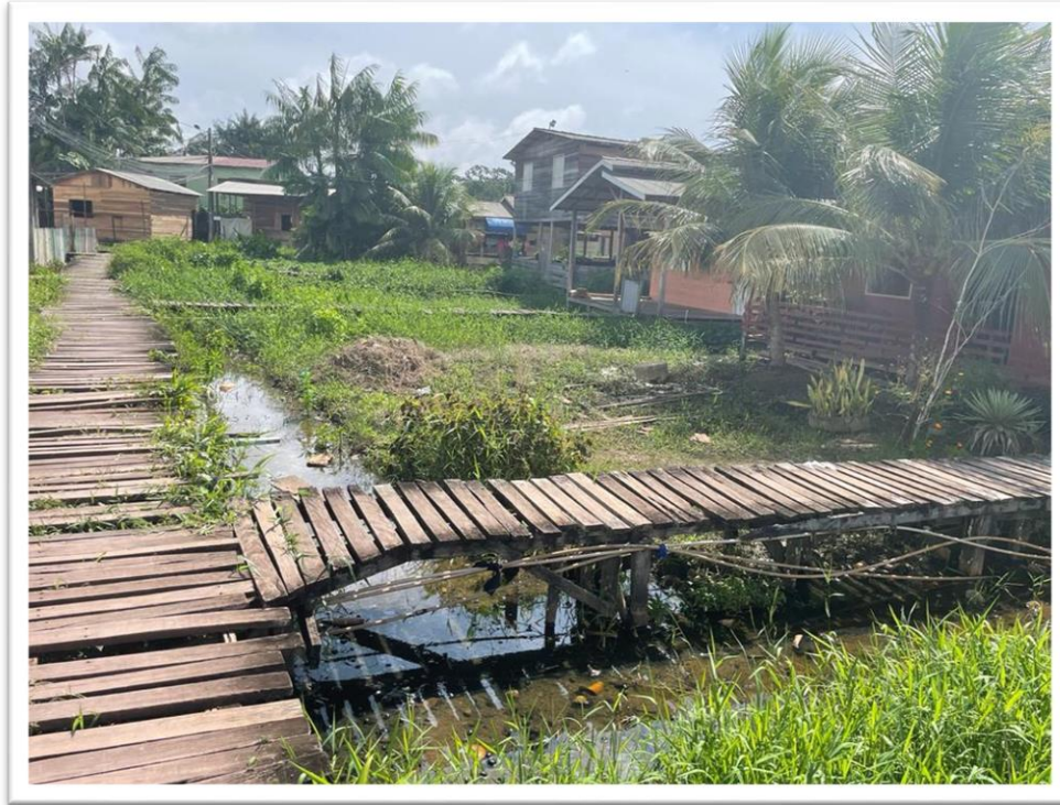
Figura 16: Pontes interligando casas em área de ressaca no bairro Pacoval.
