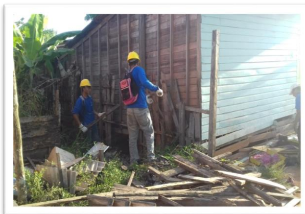
Figura 21: Demolição das casas dos moradores.
