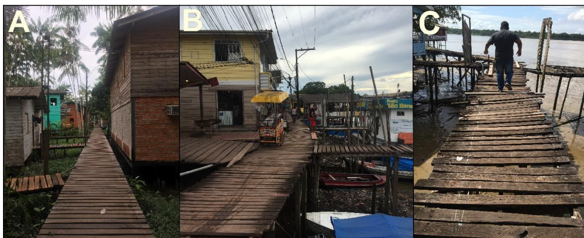
Figura 24 - Infraestrutura das moradias e passarelas
