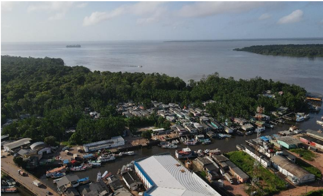
Figura 4: Conjunto de palafitas às margens do Igarapé da Fortaleza
