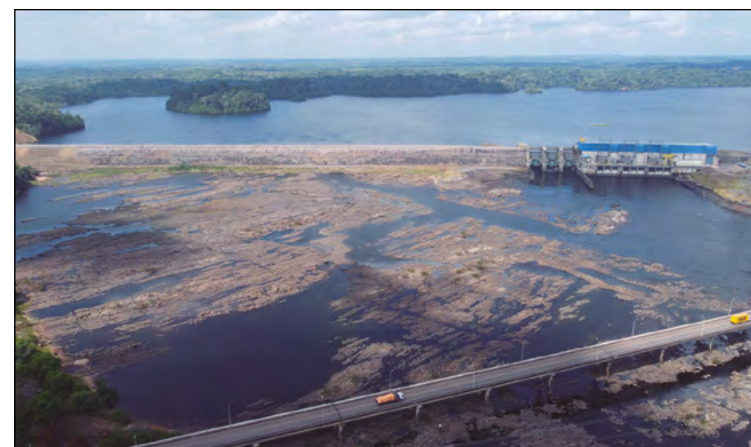
Figura 45: Barramento da Usina Hidrelétrica de Ferreira Gomes Fonte: Silva Junior (2024)
