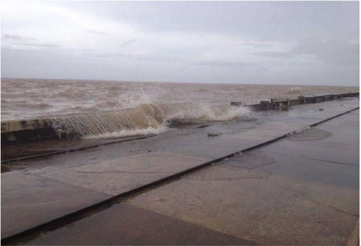
Figura 18 - Avanço do Rio Amazonas sobre o muro de arrimo
