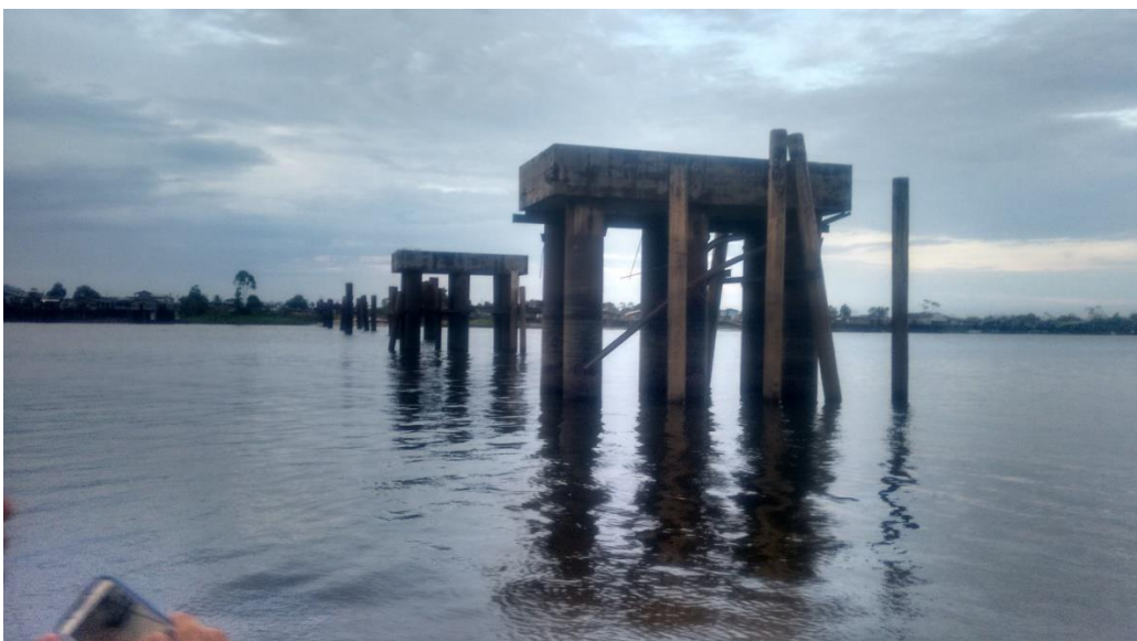
Figura 12: Estrutura da ponte sobre o rio Jari que ligaria Monte Dourado/PA a Laranjal do Jari/AP.
