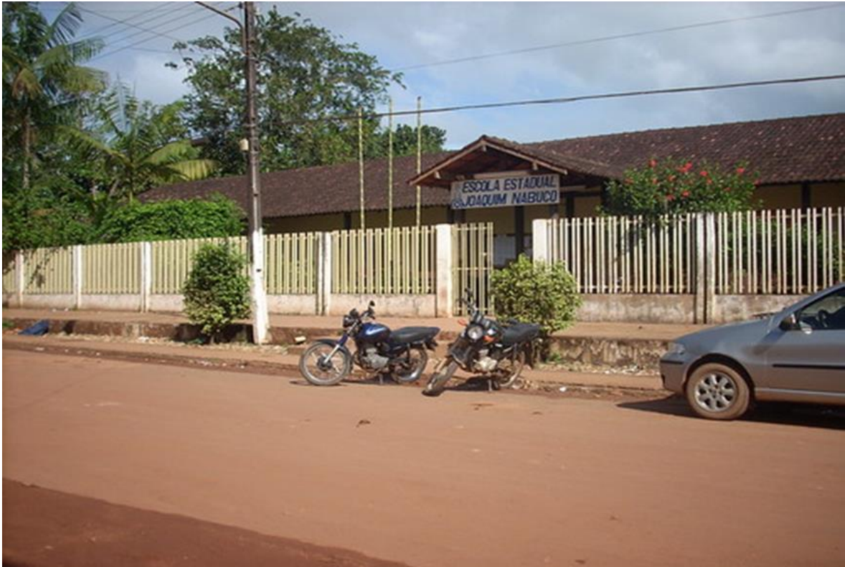
Figura 11. Escola Joaquim Nabuco no município de Oiapoque.
