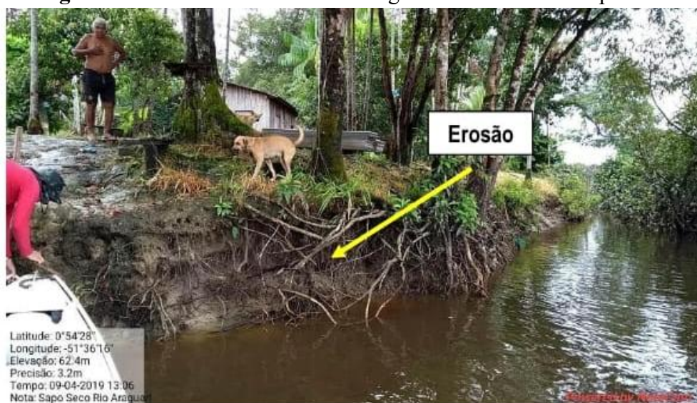
Figura 12 - Erosão no Médio Rio Araguari - Comunidade Sapo Seco
