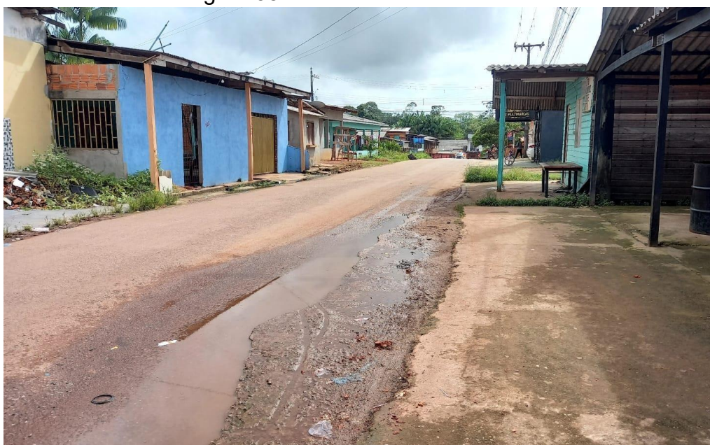
Figura 38 - Rua má conservada
