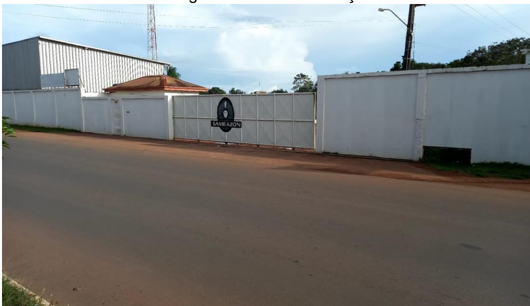
Figura 05 - Fábrica de açaí
