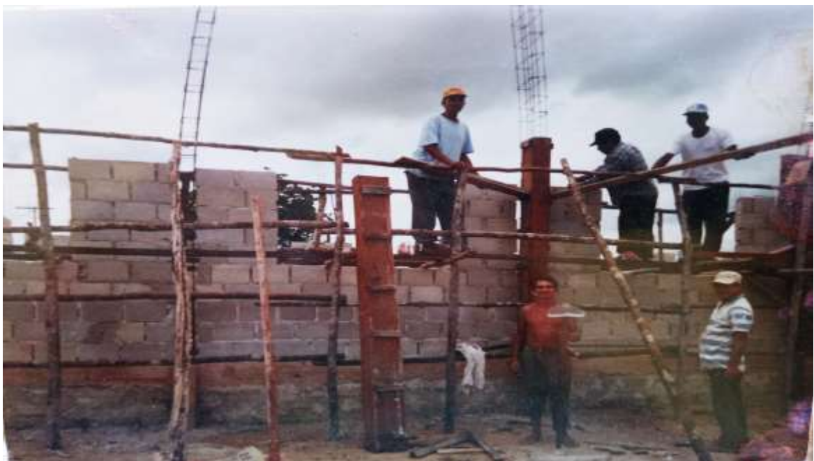
Fotografia 8 -Construção de ponte de concreto, trecho Ferreira Gomes/Amapá/Calçoene
