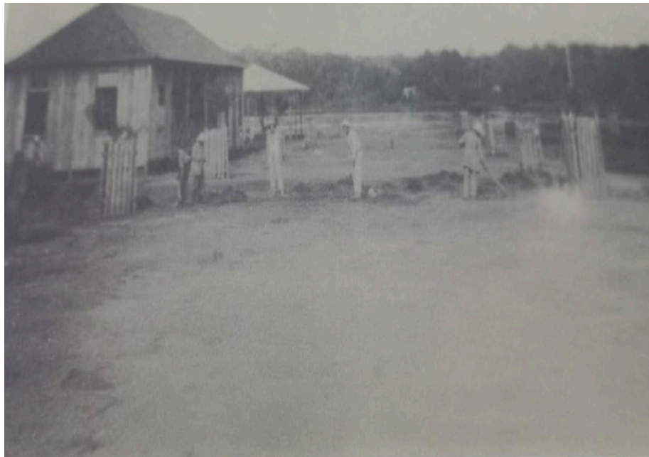
Figura 5 – Prisioneiros trabalhando na construção de vias públicas de Clevelândia
