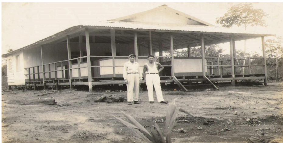
Figura 15 – Rocque e Geraldo Lod na construção da escola da aldeia Galibi
