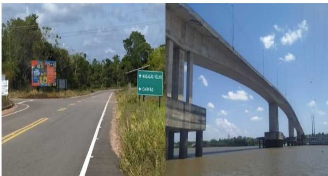
Figura 1 – Rodovia AP-010 e Ponte Washington Elias dos Santos
