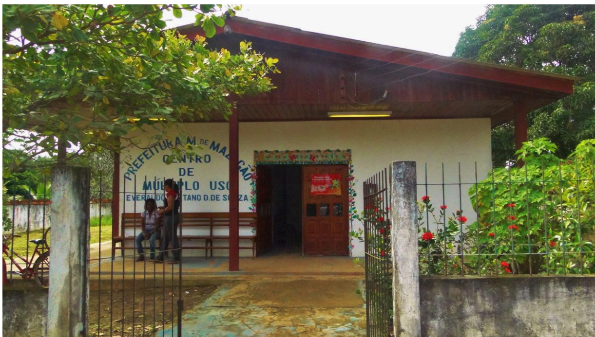
Figura 22 - Centro de Múltiplo Uso de Mazagão.
