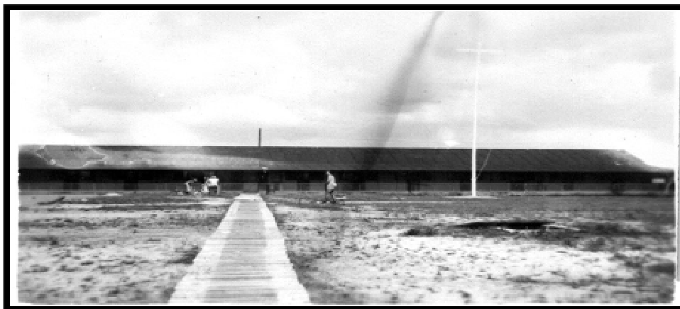
Fotografia nº 3: Imagem de um dos prédios construído na Base aérea do Amapá, entre 1943 e 1945.
