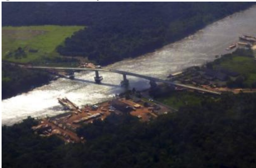
Figura 3. Ponte sobre o Rio Matapí com 600 metros
