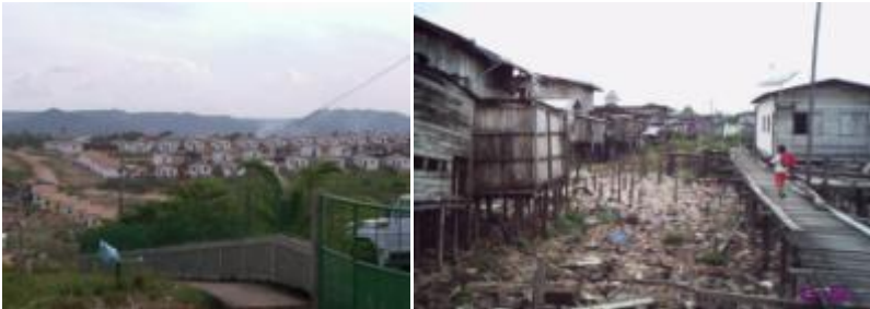
Figura 3 e 4. Cidade de Laranjal do Jari evidenciando as características do núcleo urbano entre a parte alta e baixa
