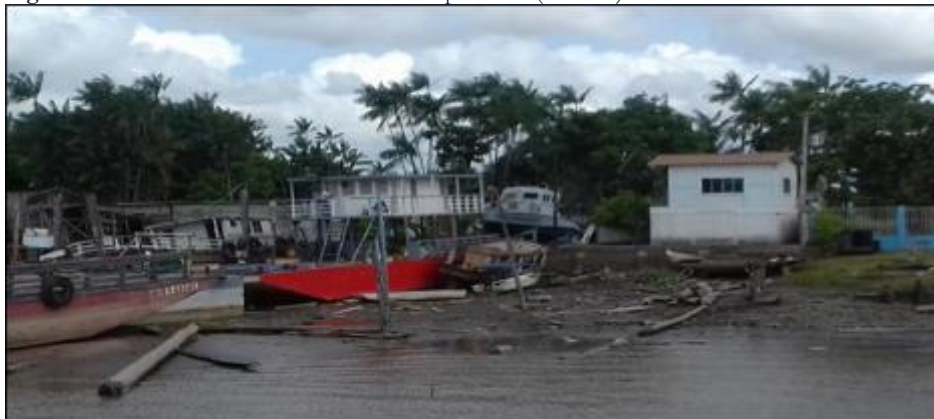
Figura 5 - Entulhos nos canais fluviais da área portuária (Ponto 3)
