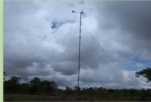
Figura 7 - Sistema eólico em Itaubal
