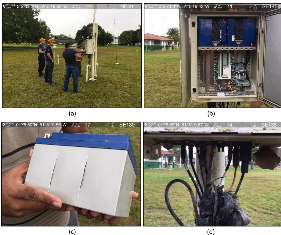
Figura 116 – Manutenção na EMA do INMET no dia 08/02/2019.
