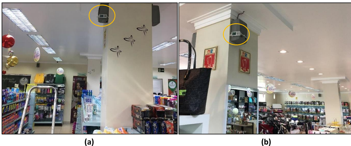
Figura 58 – Equipamento datalogger Hobo UX100-003 instalado no centro da Loja Estação Beleza de frente para a entrada. (a) Instalado na caixa de som do primeiro piso e (b) Instalado no segundo piso.
