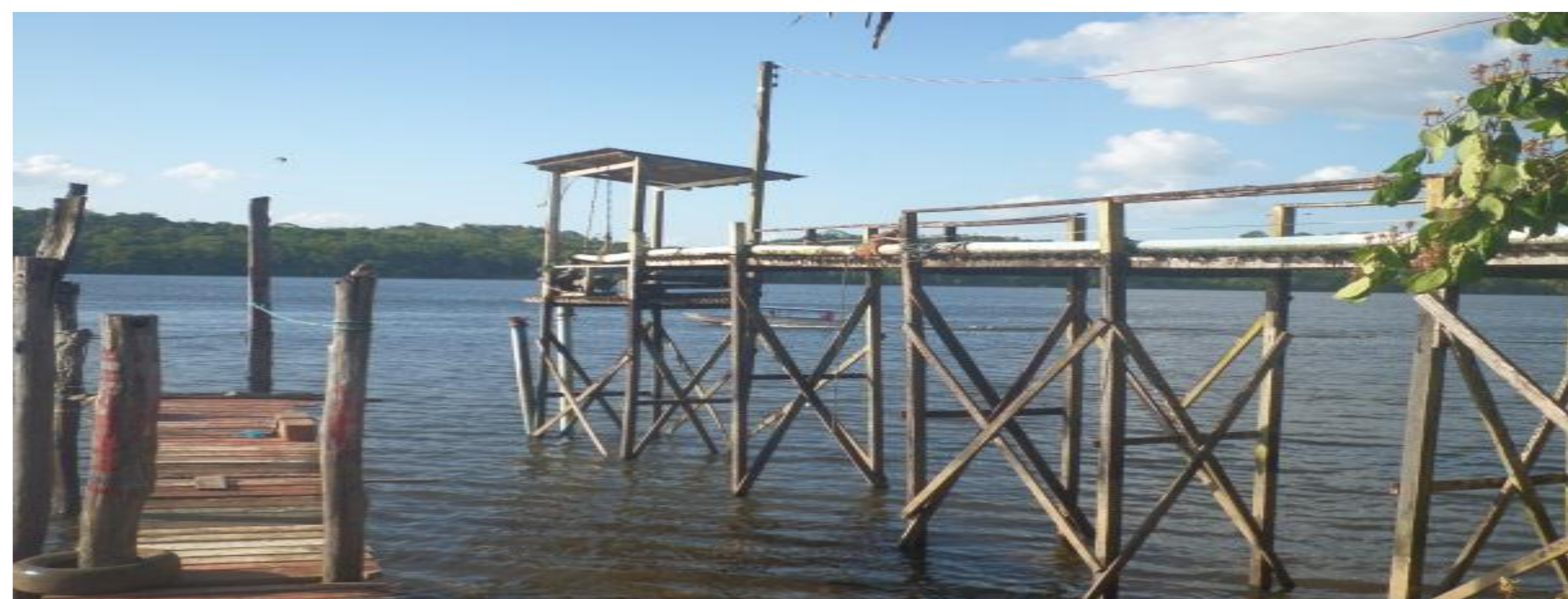
Figura 1. Captação de água no Rio Oiapoque. Fonte: Autores. Outubro. 2019.
