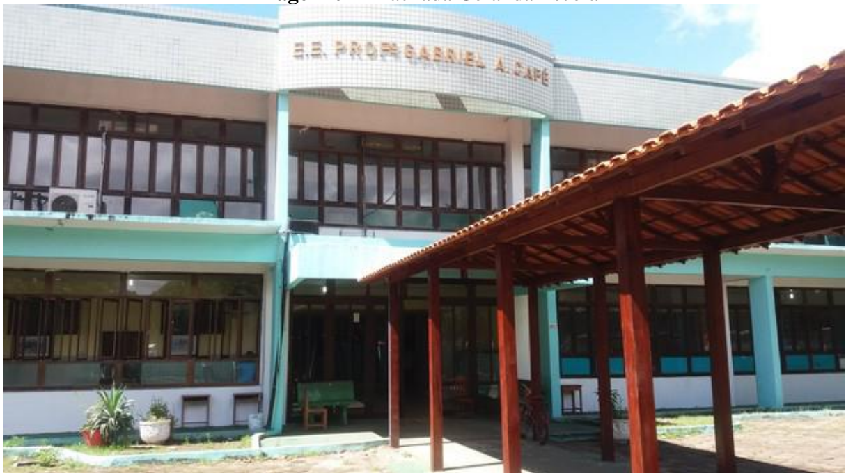
Imagem 01 – Fachada Geral da Escola
